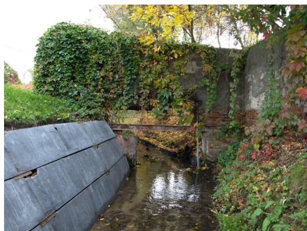
Fot.12 Fragment umocnienia płytami betonowymi lewego brzegu cieków oraz mur przechodzący nad ciekami.
