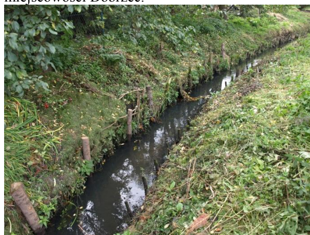
Fot.6 Widoczne umocnienia ciek w postaci faszyny - w miejscowości Dobrzec.
