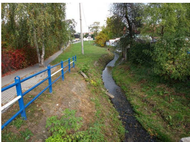
Fot.13 Widok na uregulowane koryto cieków – widok z ul. Ogrodowej w m.Kalisz
