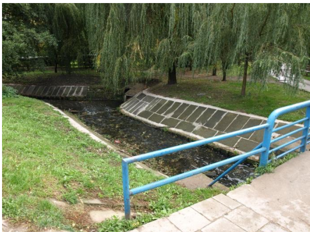
Fot.9 Widok z kładki w parku im. Urszulki Urbanowskiej w Kaliszu na całkowicie umocnione skarpy brzegowe.
