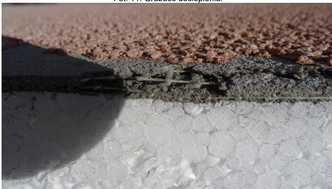
Fot. 12. Dwie siatki na zakładzie.
