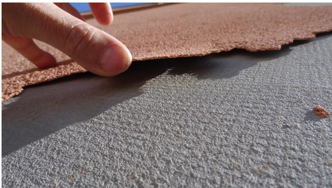
Fot. 7. Uszkodzenia tynku elewacji.
