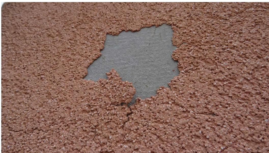
Fot. 4. Uszkodzenia tynku elewacji.
