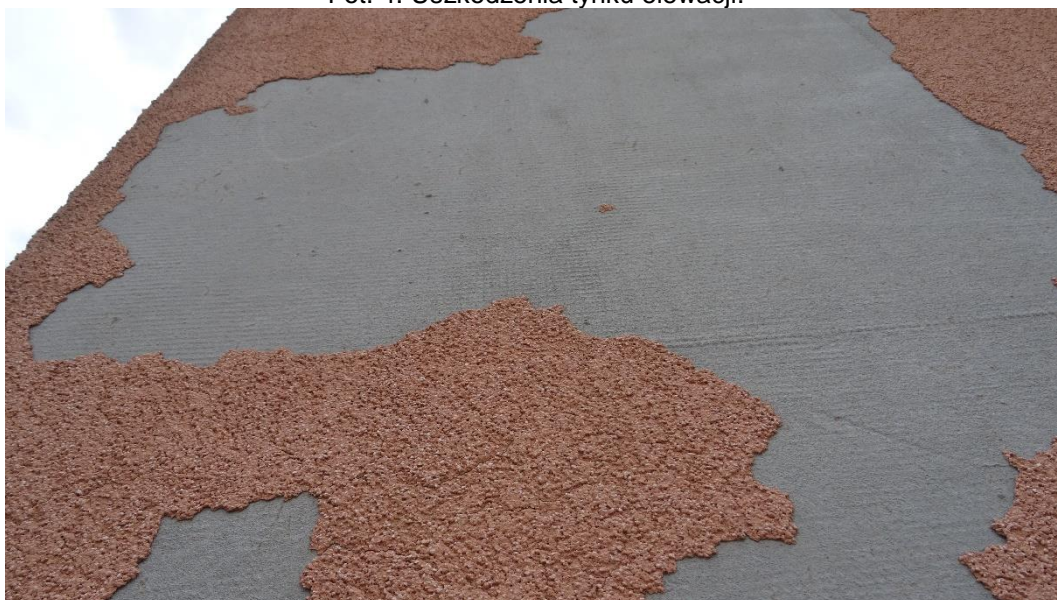
Fot. 5. Uszkodzenia tynku elewacji.
