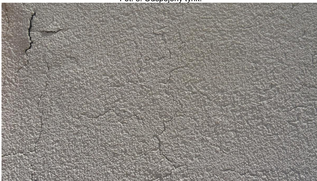
Fot. 9. Uszkodzenia tynku elewacji.
