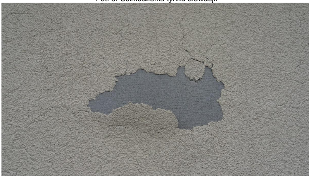
Fot. 6. Uszkodzenia tynku elewacji.
