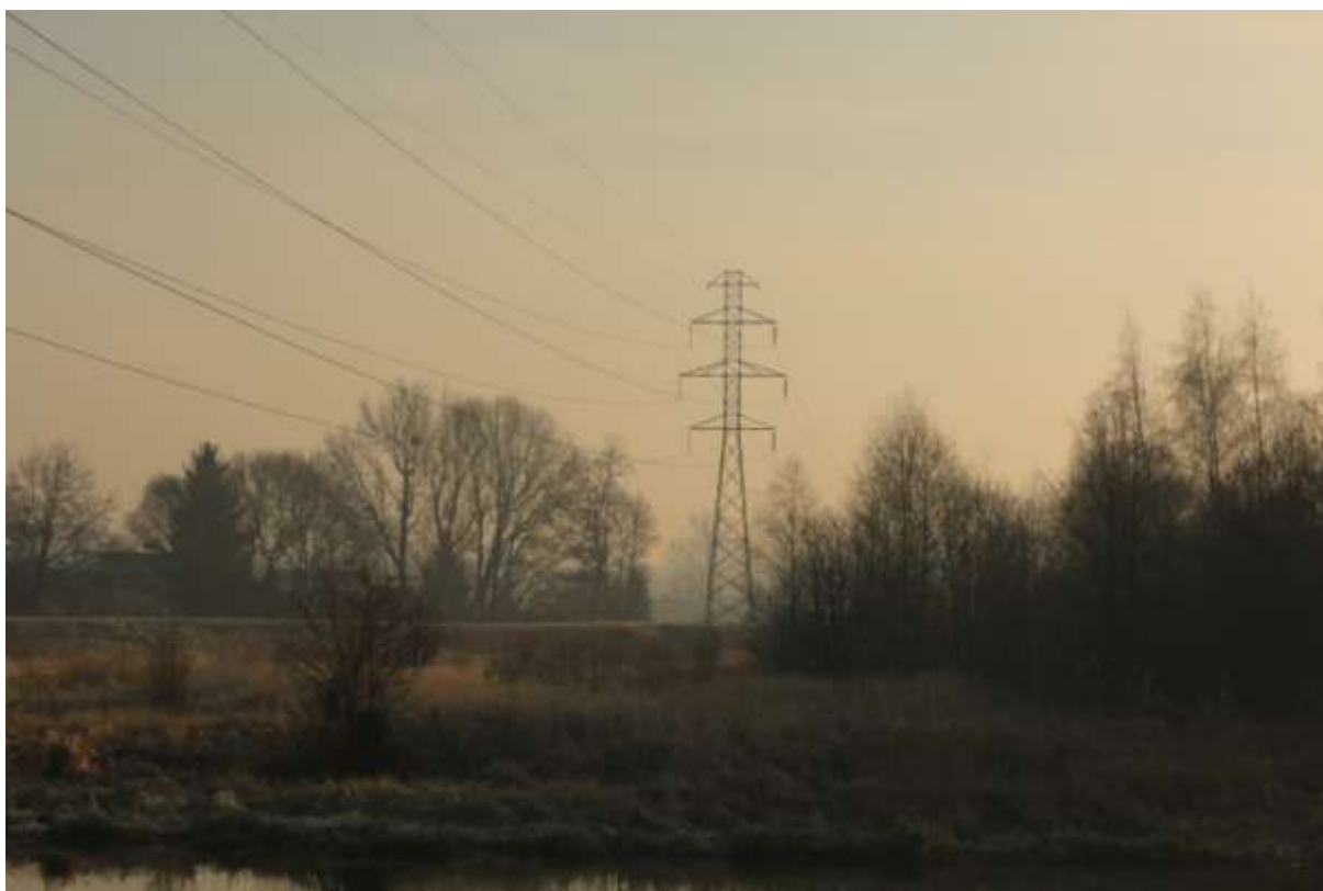
Fot. 6. Widok z ul. Wał Piastowski na przekroczenie rzeki Proсны przez linię elektroenergetyczną 110 kV. Widoczny słup linii elektroenergetycznej na projektowanym terenie 8.E.
