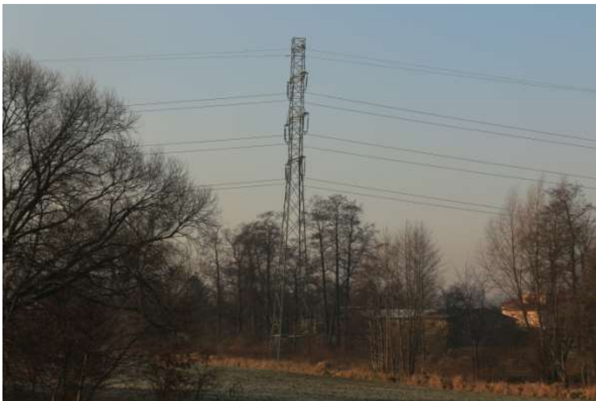
Fot. 5. Widok z ul. Wał Piastowski na słup linii elektroenergetycznej 110 kV na projektowanym terenie 6.E.
