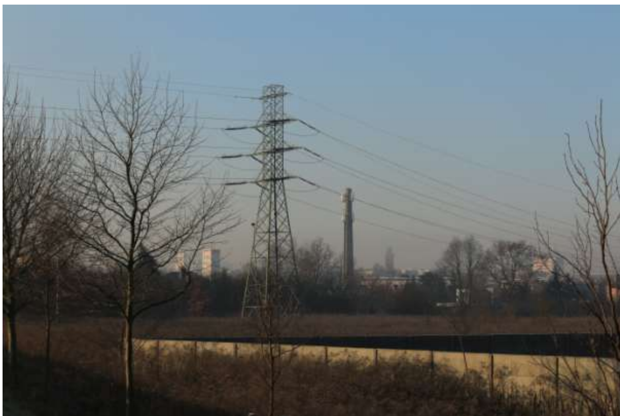
Fot. 2. Widok na słup linii elektroenergetycznej 110 kV na projektowanym terenie 2.E.
