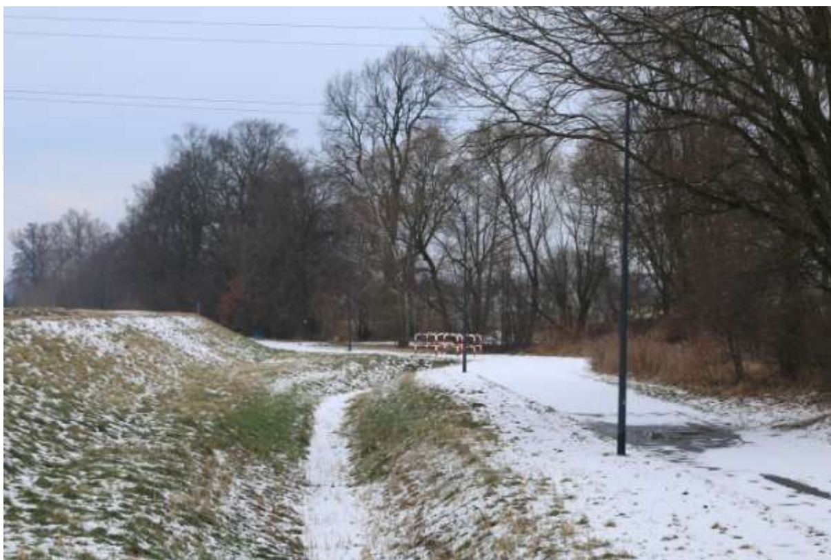
Fot. 10. Widok na przekroczenie drogi wewnętrznej wzdłuż wału przeciwpowodziowego przez linię elektroenergetyczną 110 kV.
