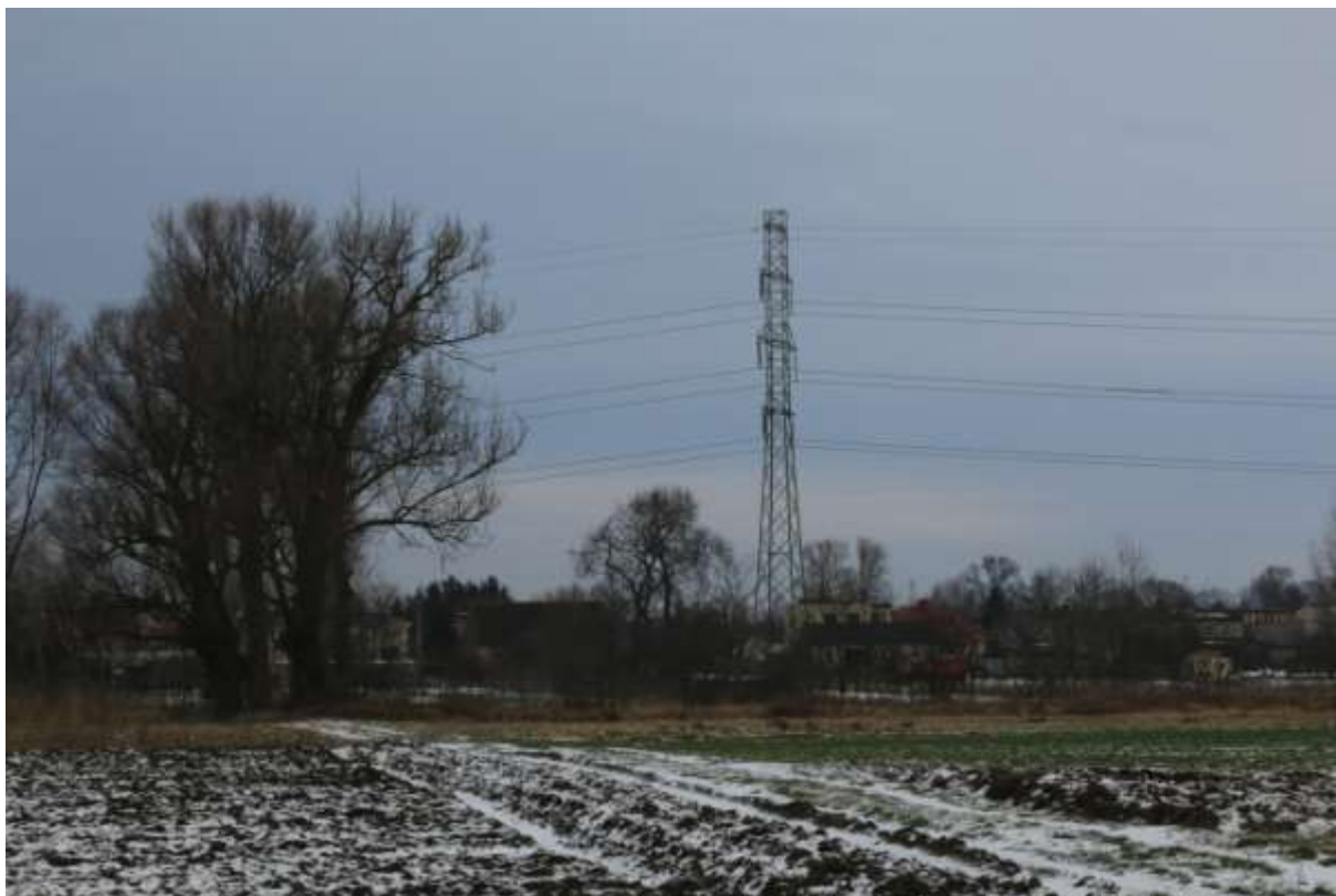
Fot. 12. Widok na słup linii elektroenergetycznej 110 kV na projektowanym terenie 9.E.
