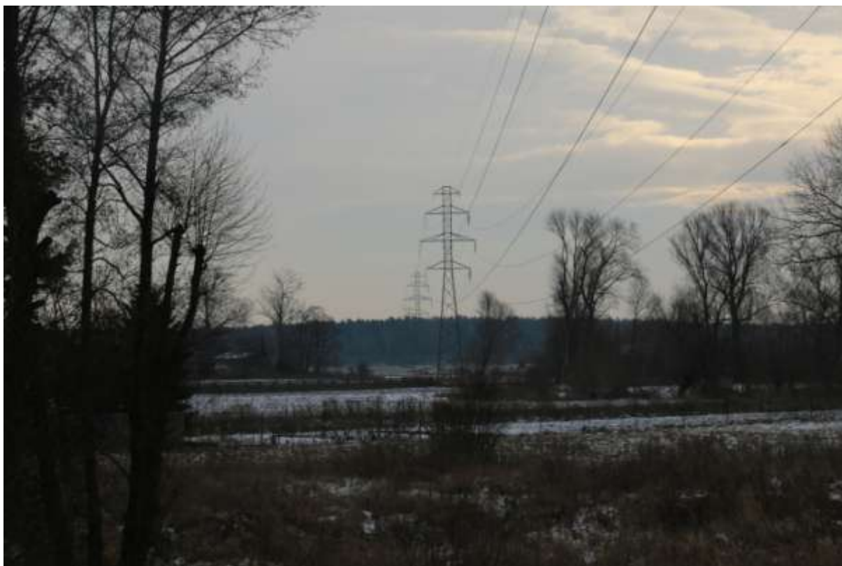
Fot. 9. Widok z wału przeciwpowodziowego w kierunku wschodnim na przekroczenie rzeki Prosny przez linię elektroenergetyczną 110 kV. Widoczny na drugim planie słup linii elektroenergetycznej na projektowanym terenie 9.E.
