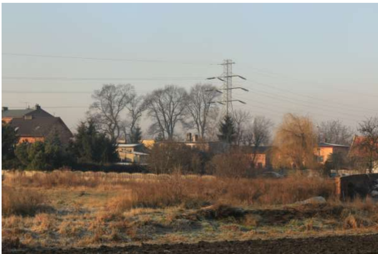
Fot. 4. Widok z ul. Wał Piastowski na przekroczenie istniejącej zabudowy przy ul. Stare Miasto przez linię elektroenergetyczną 110 kV. Widoczny słup załomowy linii elektroenergetycznej na projektowanym terenie 4.E.
