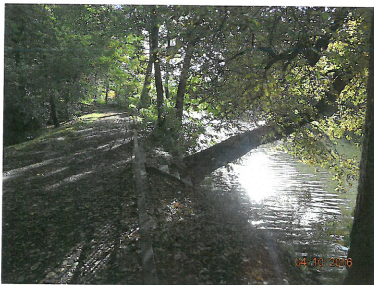
Fot. 4 Km 0+500 Wał prawostronny rz. Prosny, drzewo pochylone w stronę rzeki
