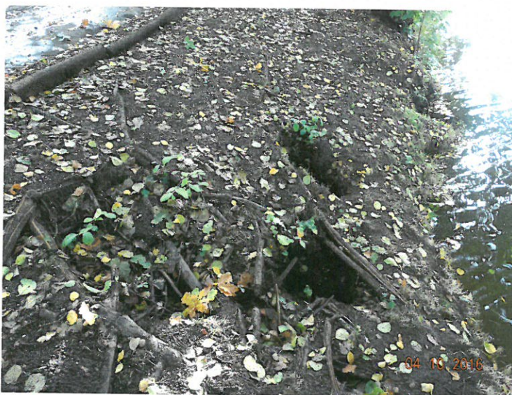
Fot. 2 Km 0+250 Wał prawostronny rz. Prosny, nora zwierzęca i podmyty system korzeniowy na skarpie odwodnej
