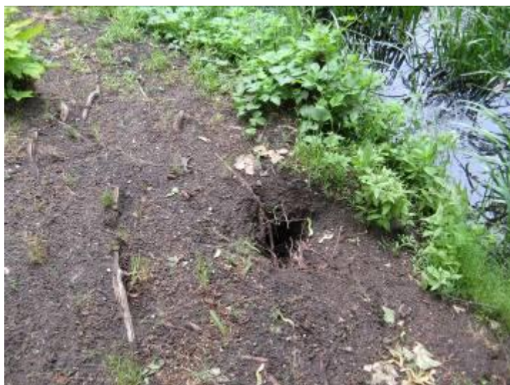
Fot. 5 Km 0+240 Wał prawostronny rz. Prosny – nora w skarpie odwodnej
