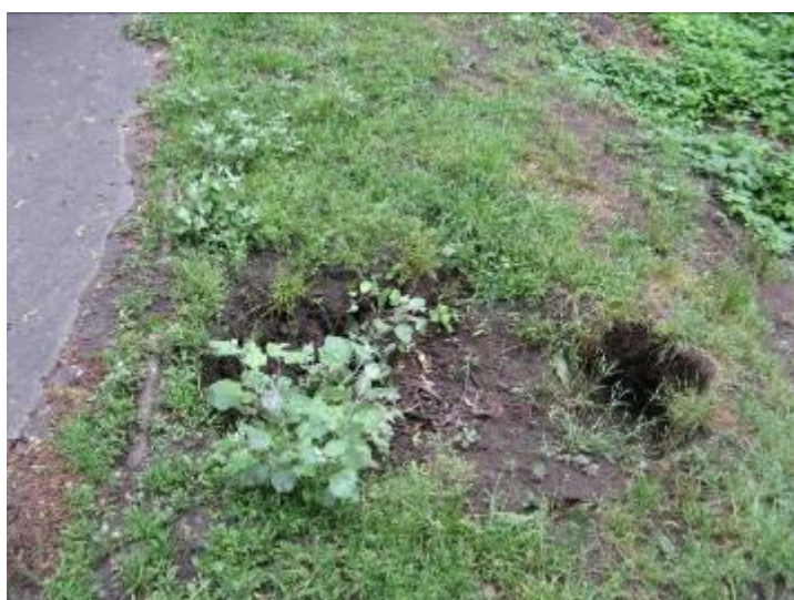
Fot. 2 Km 0+140 Wał prawostronny rz. Prosny – uszkodzenie skarpy odwodnej
