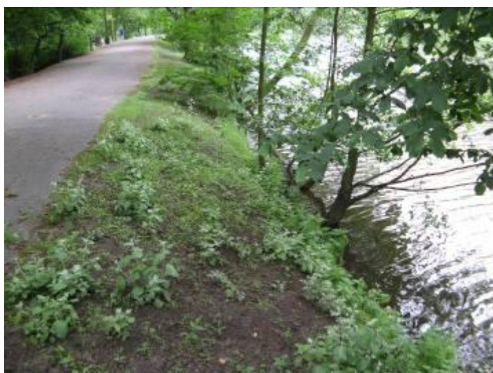
Fot. 3 Km 0+185 Widok na wał prawostronny rz. Prosny – podmyta stopa skarpy odwodnej
