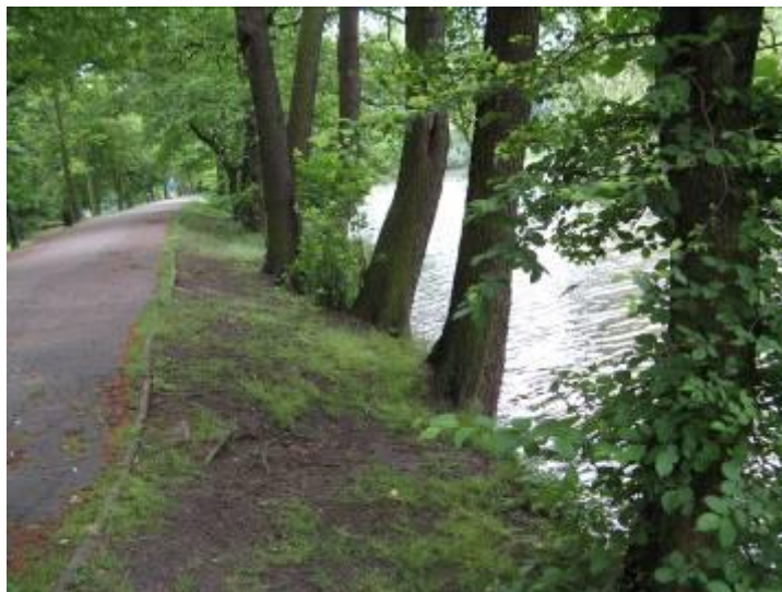
Fot. 4 Km 0+195 Widok na wał prawostronny rz. Prosny – drzewa w skarpie odwodnej
