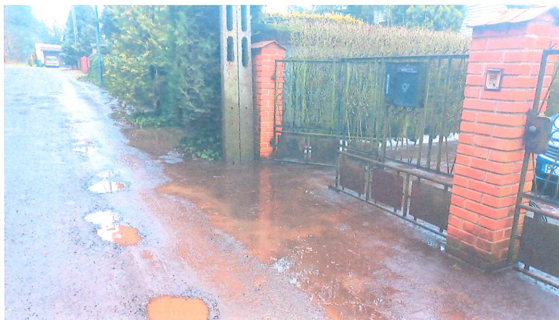
Fot. 4. Zalegająca woda na podjeździe do posesji pod adresem Bizantyjska 6
